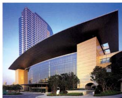
ASEMセンター(ASEM Convention Center)の屋根
